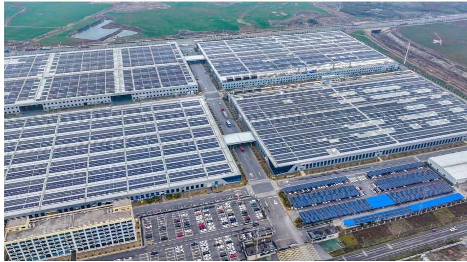
图 4-13：晶科能源（滁州）有限公司屋顶光伏
