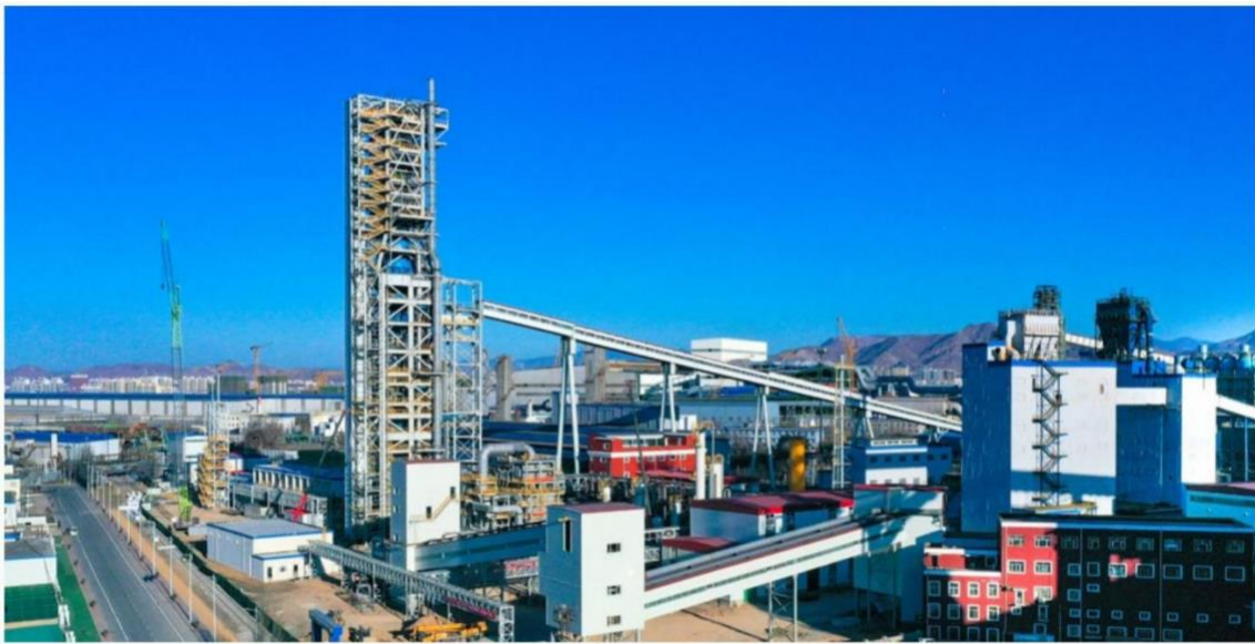
图 4-2-14 河钢集团氢冶金示范工程
