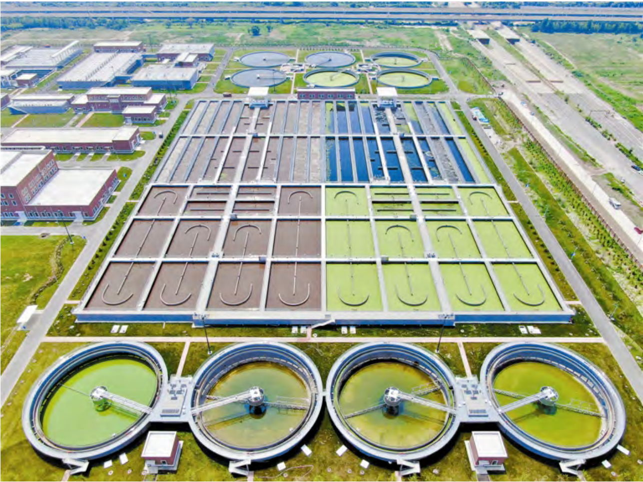
图 109：天津市处理能力最大的污水处理厂，张贵庄污水处理厂 31
