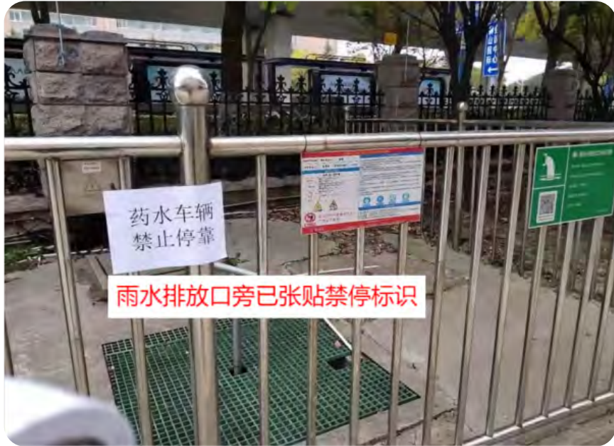
图 101：毅嘉电子开展防渗漏整治与提升现场照片 28
