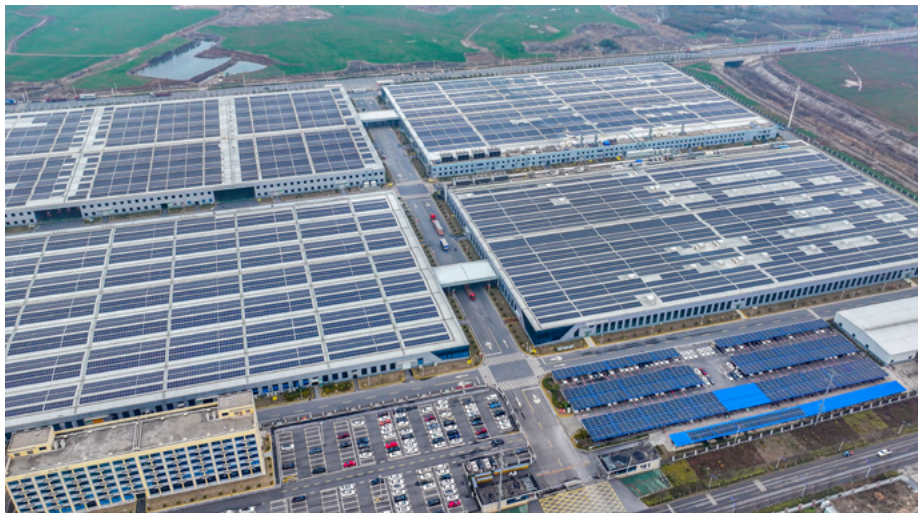
图 4-13：晶科能源（滁州）有限公司屋顶光伏
