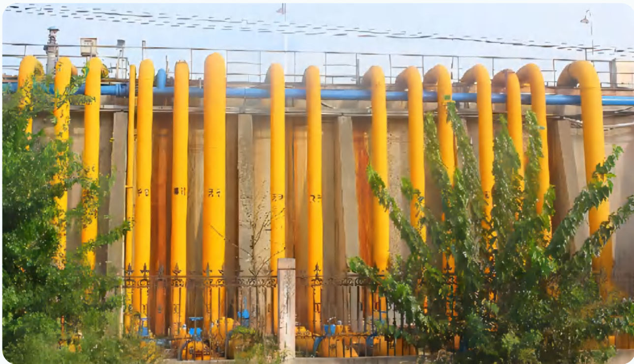
图 70：党湾污水处理厂各企业废水进水管
